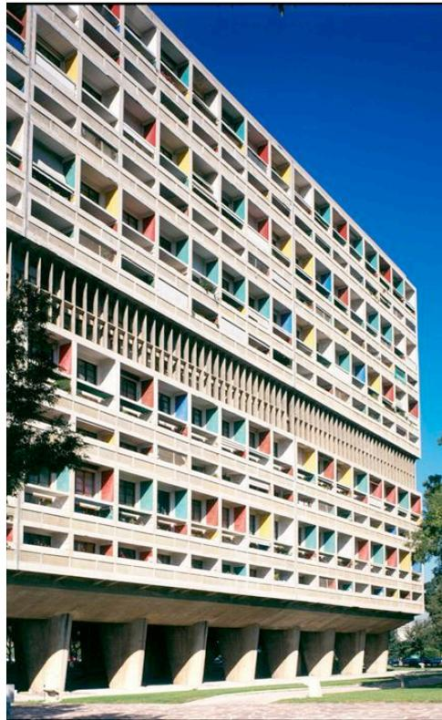
Figura 9: Unidade de habitação de Marselha. Detalhe do *brise soleil*
